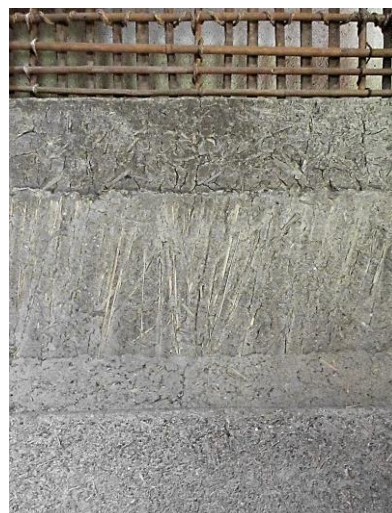
Estructura de la Tsuchi kabe
